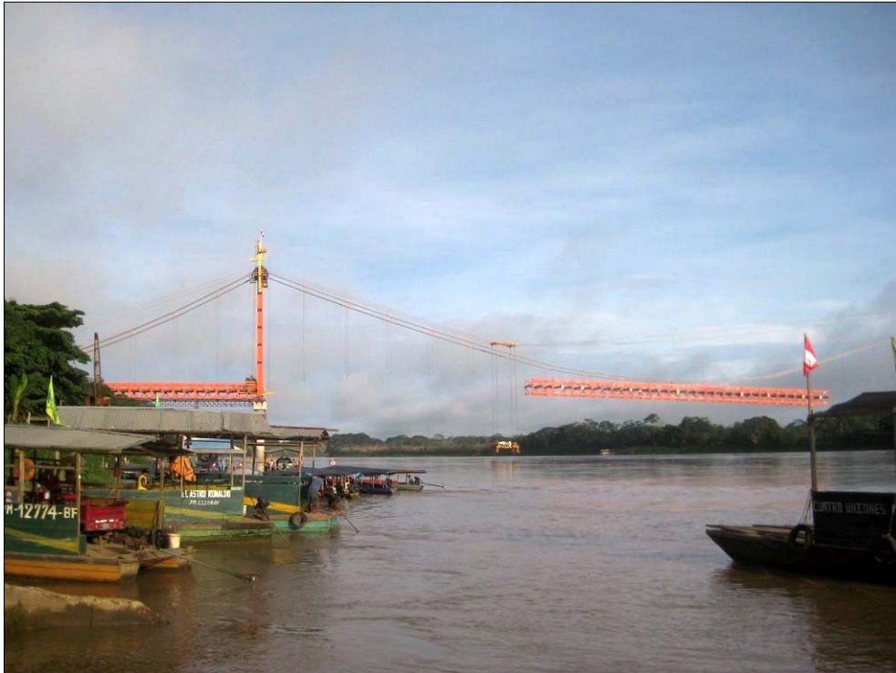
빌링거스트 다리 건설 현장
