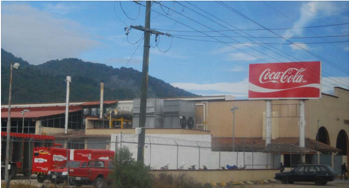
그림 14. 치아파스 산골의 코카콜라 공장
