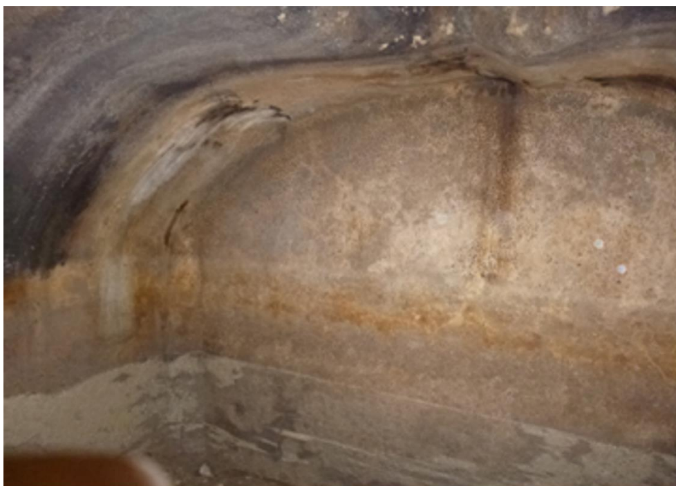
Fig. 22: Interno cisterna, volta e rivestimento (foto GSAGS).
