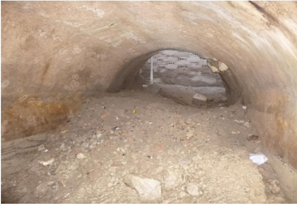
Fig. 23: Interno cisterna. Copertura voltata: sul fondo è visibile il muro in mattoni forati dell'edificio moderno (foto GSAGS).
