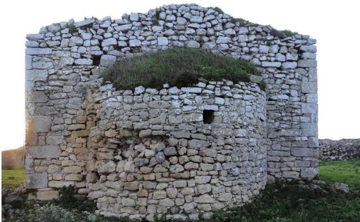
Fig. 5. Sant'Antonio, chiesa diroccata del villaggio abbandonato di Thaylos (Torralba).
