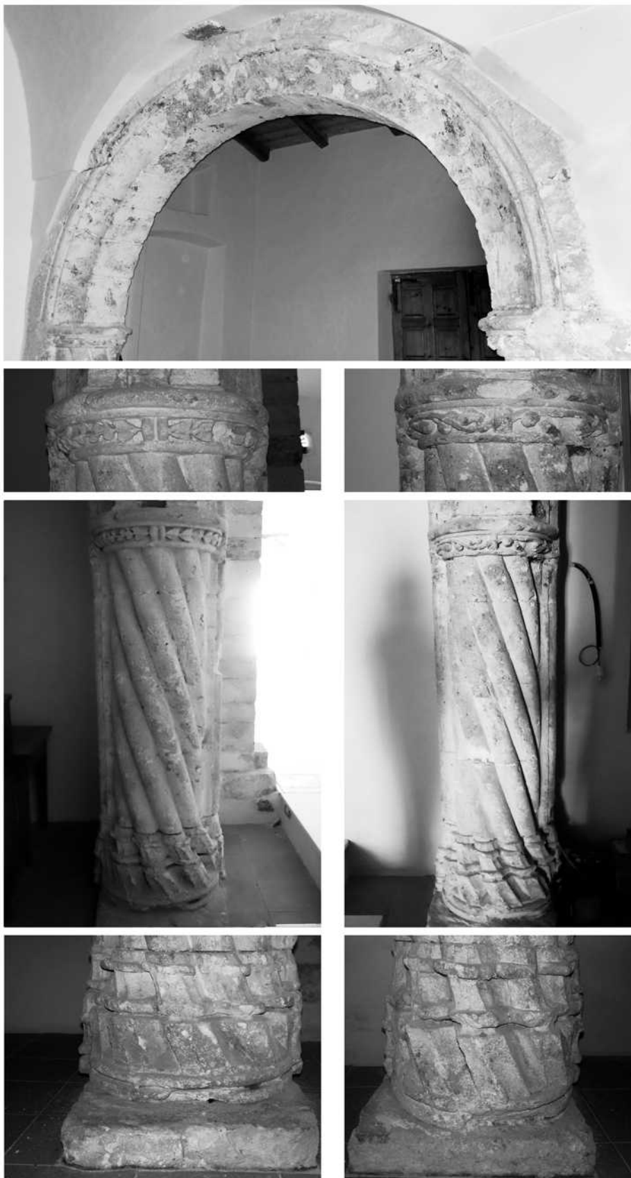
Fig. 7. Arco ed elementi dei pilastri di maniera gotico-catalana.
