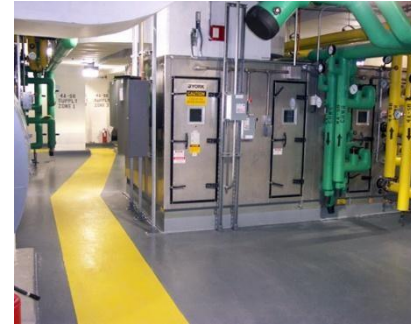
gambar 3. 5 AHU
