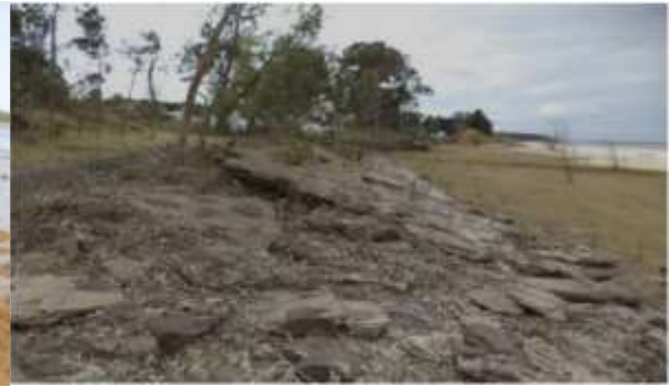
Foto del autor: Barranca con muro de defensa
