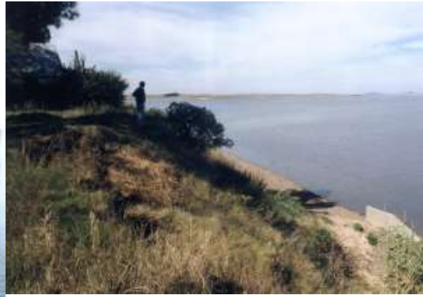
Foto del autor: Barranca sin muro de defensa
