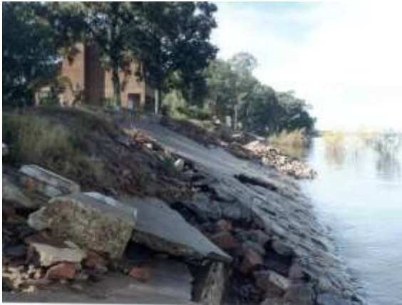
Foto del autor: Barranca con muro de defensa
