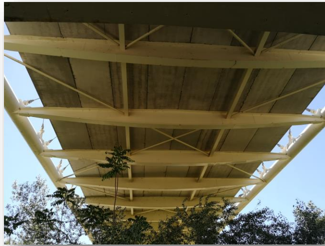
Figura 4 Referencia viga transversal
