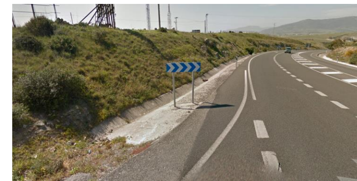
Figura 1-21: Desmonte en la bifurcación del movimiento Cádiz-Tarifa
