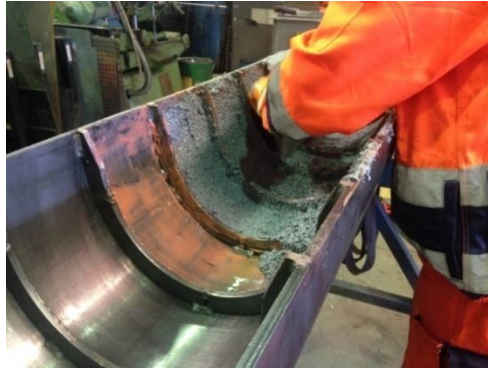
Figura 2.50. Aplicación de resinas de reconstrucción y antidesgaste.
