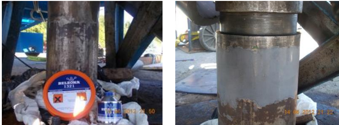
Figura 2.46. Reparación con Belzona de eje dañado. (Fuente:
