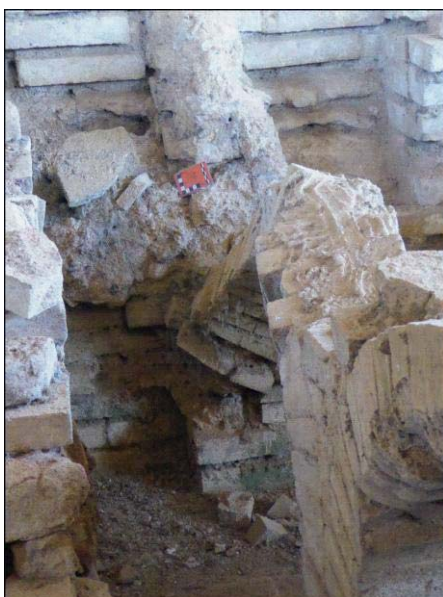
FIGURA 2. Ejemplo de una de las deformaciones presentes en el yacimiento: rotación y desplazamiento de un arco de ladrillo en las termas de la ciudad (ver Fig.1).
