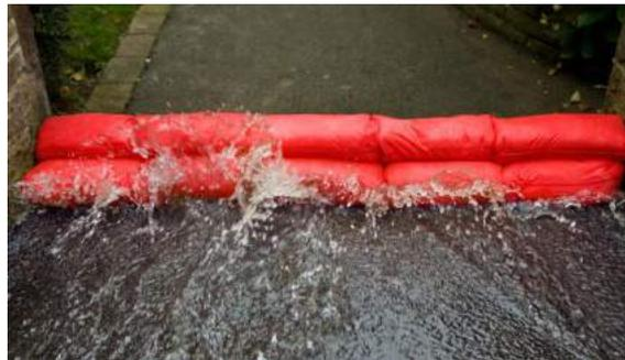
Figura 6-7. Barrera de protección Hydrosack [32].
