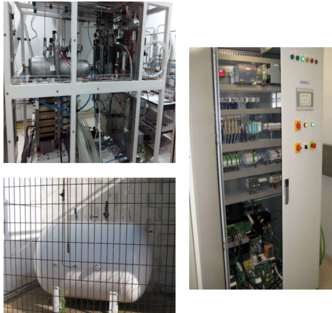
Figura 3.8 Electrolizador y depósito de hidrógeno. Fuente: INTA.
