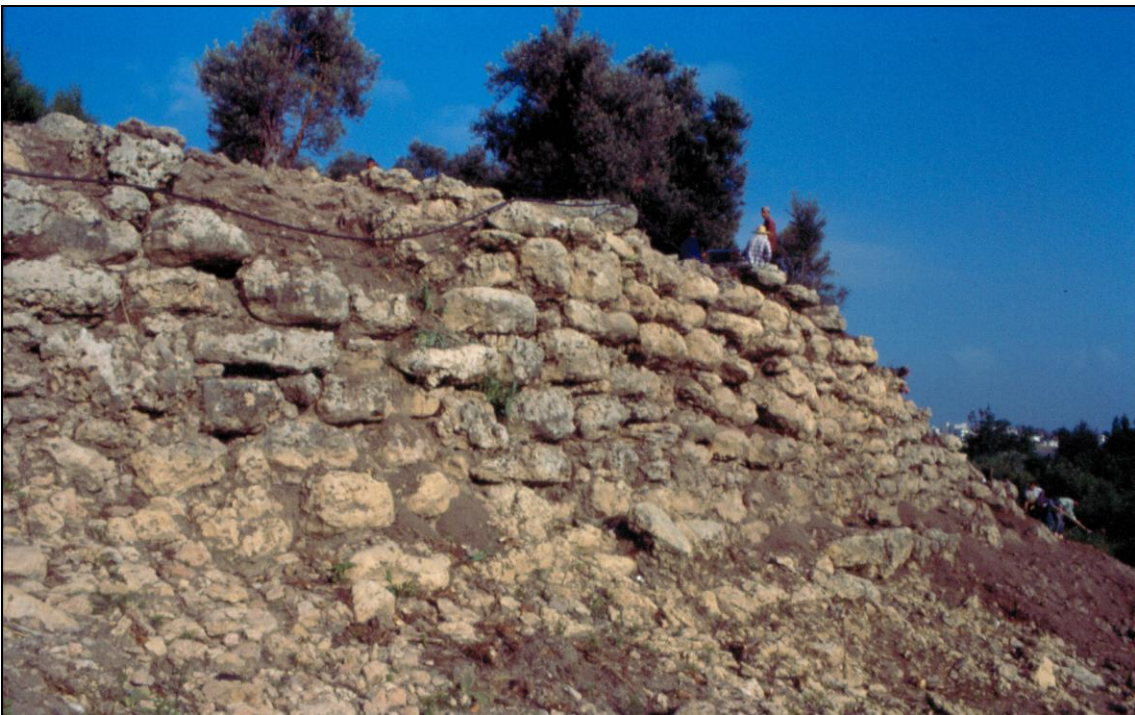
Ill. 14. Encéinte du chantier C, vue vers le nord
