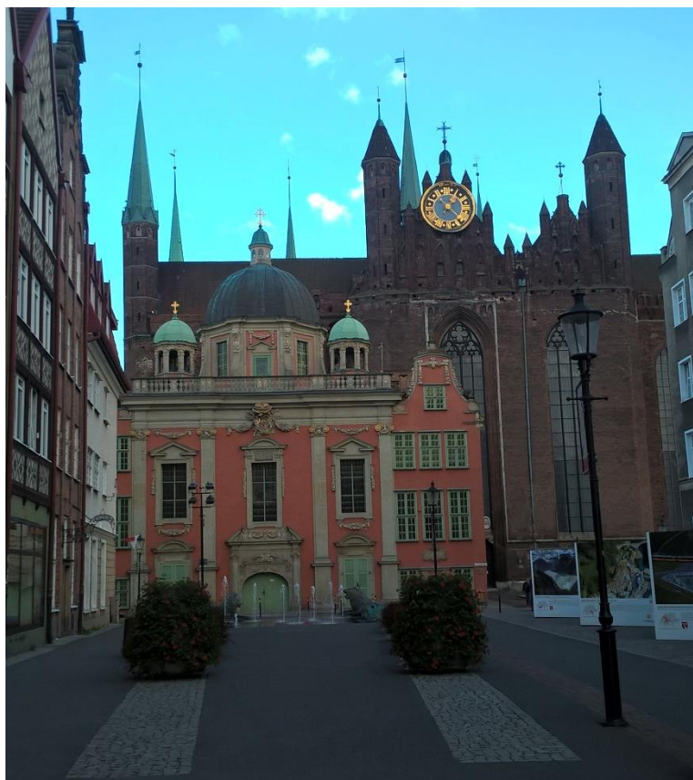
Slika 10. Kraljevska kapelica, pogled na glavno pročelje, 2016. godina
