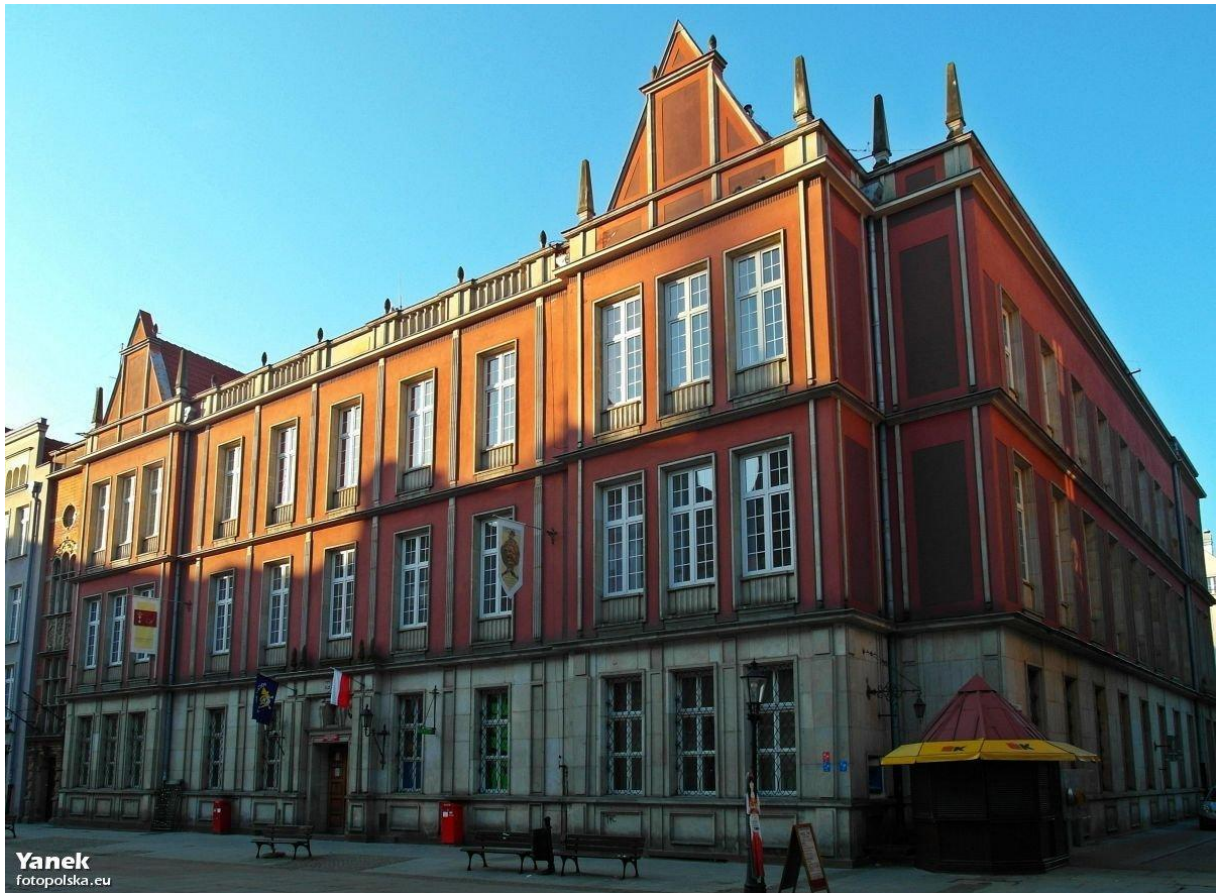
Slika 29. Zgrada pošte, glavno pročelje, 2012. godina
