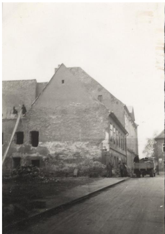
Slika 25. Vranicanijeva ulica, rušenje ostataka zagrebačkoga kapucinskoga samostana, 1940. – 1941., Zagreb, Fototeka Muzeja grada Zagreba.
