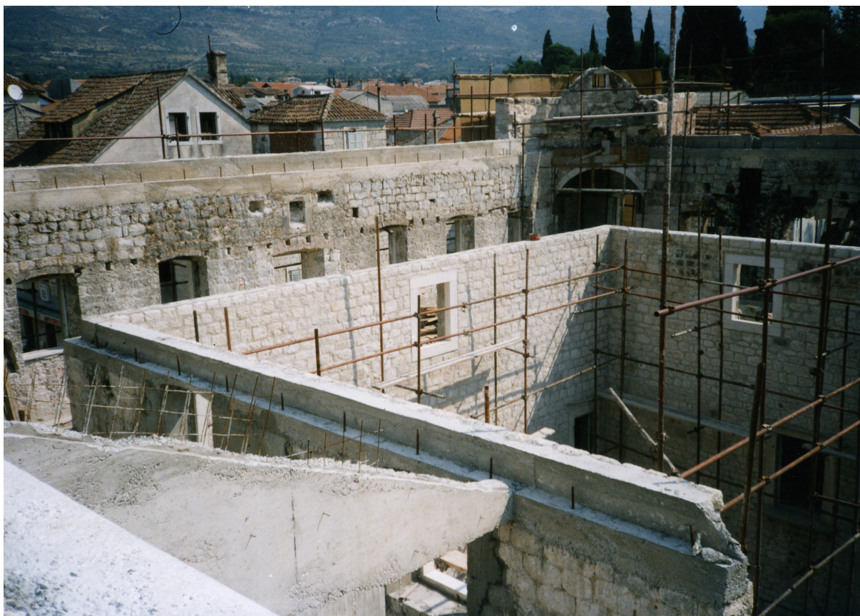
Slika 27. Kaštel Vitturi. Izvođenje radova prilikom obnove, 1993. (snimila K. Marasović)
