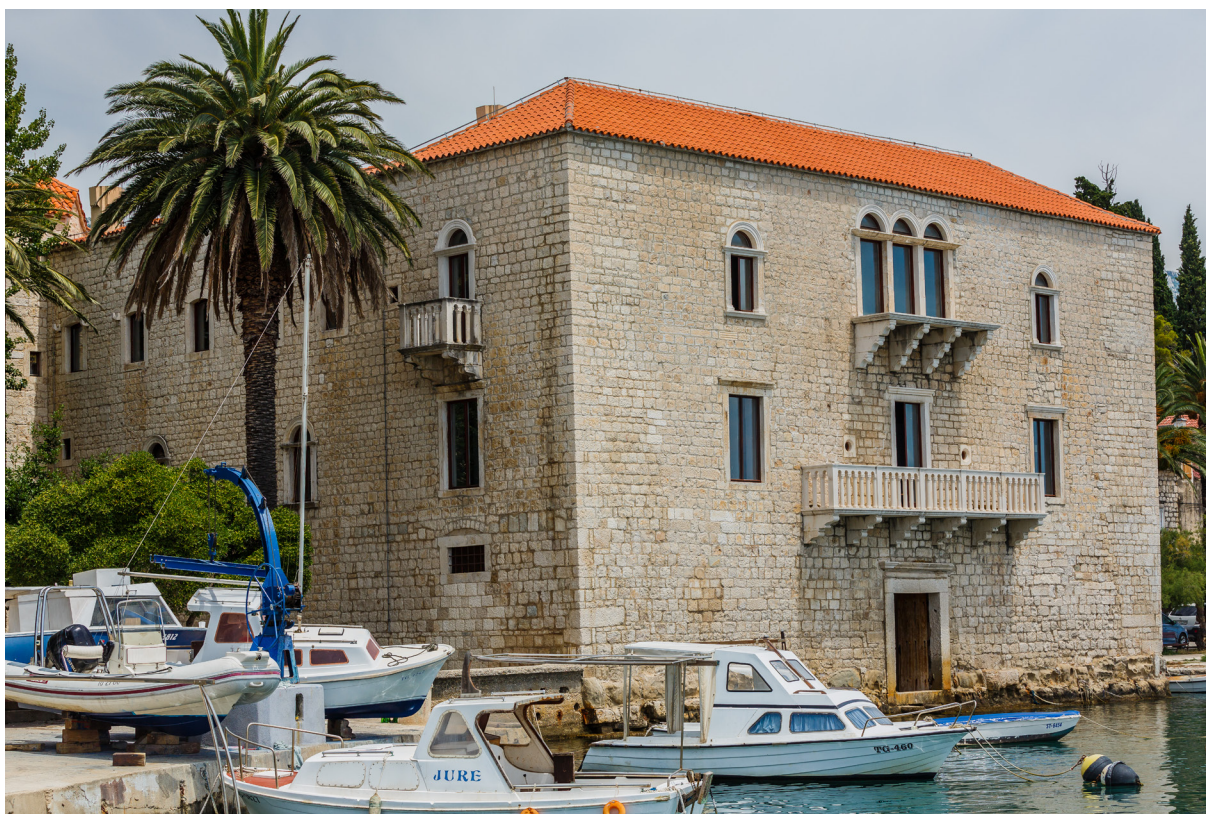
Slika 5. Kaštel Vitturi, južno i zapadno pročelje, 2016. (snimio Z. Barišin)
