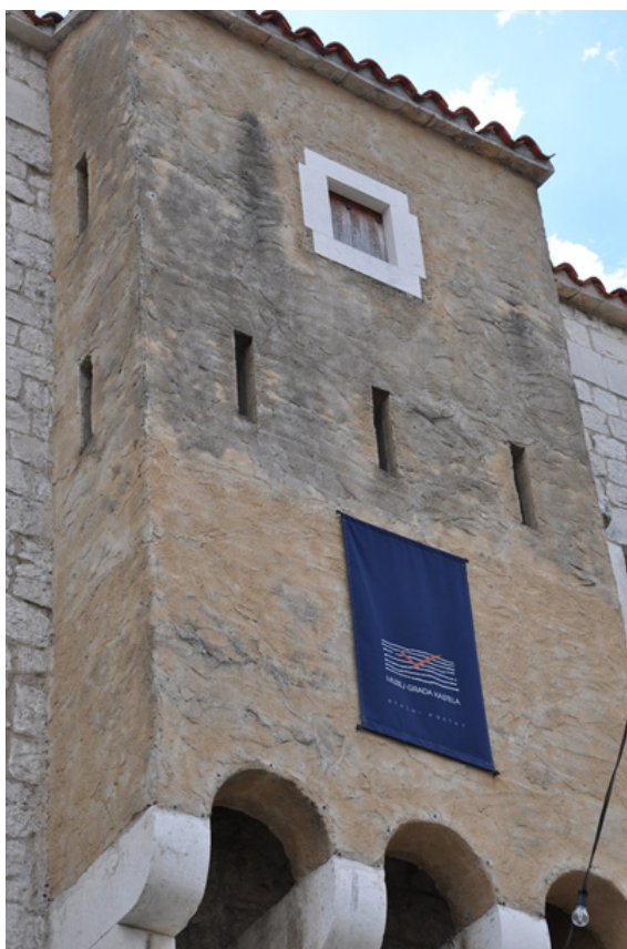
Slika 36. Kaštel Vitturi, breteš na sjevernom obnovljenom pročelju, 2016. (snimila B. Petrović)
