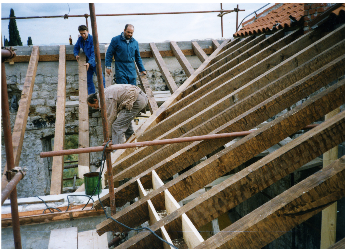
Slika 39. Kaštel Vitturi, radovi na krovnoj konstrukciji, 1993. (snimila K. Marasović)
