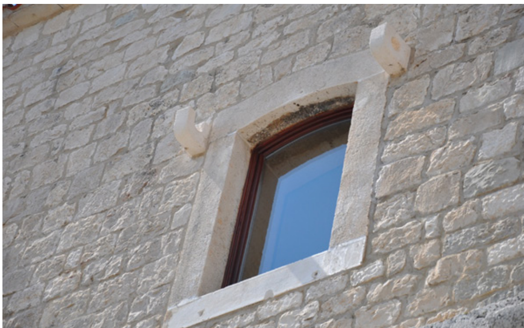
Slika 42. Kaštel Vitturi, obrambeni prozor sa probušenim konzolama, 2016. (snimila B. Petrović)
