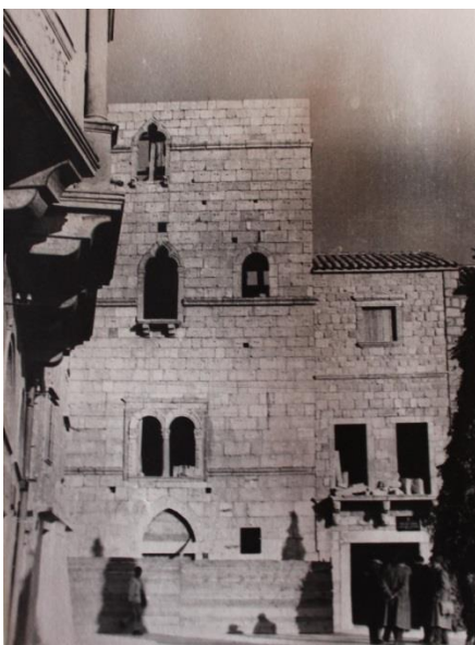
Slika 19: a) numerirani kvadri kule tijekom rušenja 20.10.1947. g. (foto: Konzervatorski odjel u Rijeci) b) stanje 15.11.1948. g. na kojem se vidi istočni zid južnog krila dvora. (foto:
