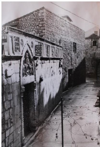
Slika 51: Palača Nimira 1959. g. s vidljivim razlikama u položaju i usmjerenju starijeg i novijeg dijela pročelja (foto: J. Vranić, Konzervatorski odjel u Rijeci)
