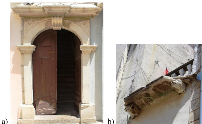
Slika 93: Građevine iz 1827. g. izgrađene na mjestu ranijeg prolaza a) portal b) pòdest balkona s konzolama u obliku lavljih glava (foto: autorica)
