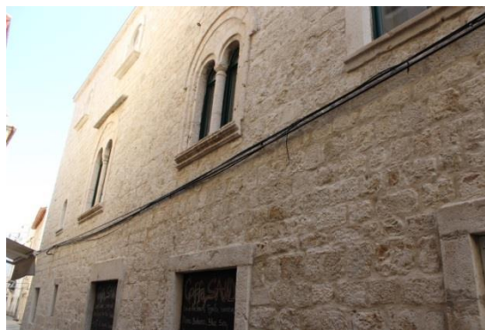
Slika 14: Zid južnog krila Kneževa dvora s pravilno uslojenim pritesanim kamenjem te dvije romaničke bifore (foto: autorica)
