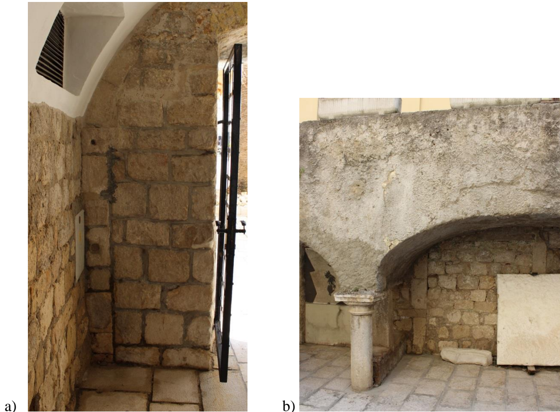
Slika 22: a) tragovi polukružno zaključenog portala b) stup i svodovi koji nose trijem te u pozadini vidljivi tragovi vjerojatno ranijeg portala (foto: autorica)
