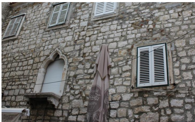
Slika 88: a) kasnogotička monofora te trag još jedne na prozoru desno s akroterijem prozora uzidanim u zid iznad b) portal sa srpastim lukom (foto: atorica)
