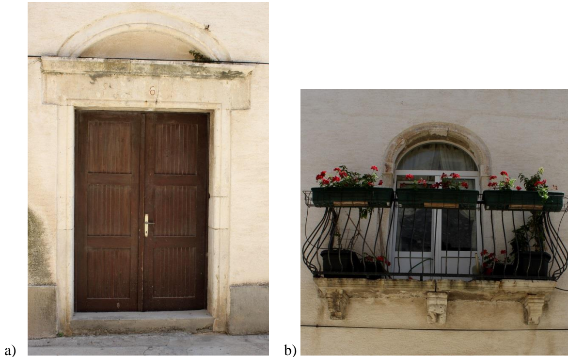
Slika 58: Stariji dijelovi građevine označene crveno na slici 56: a) portal b) balkon (foto: autorica)
