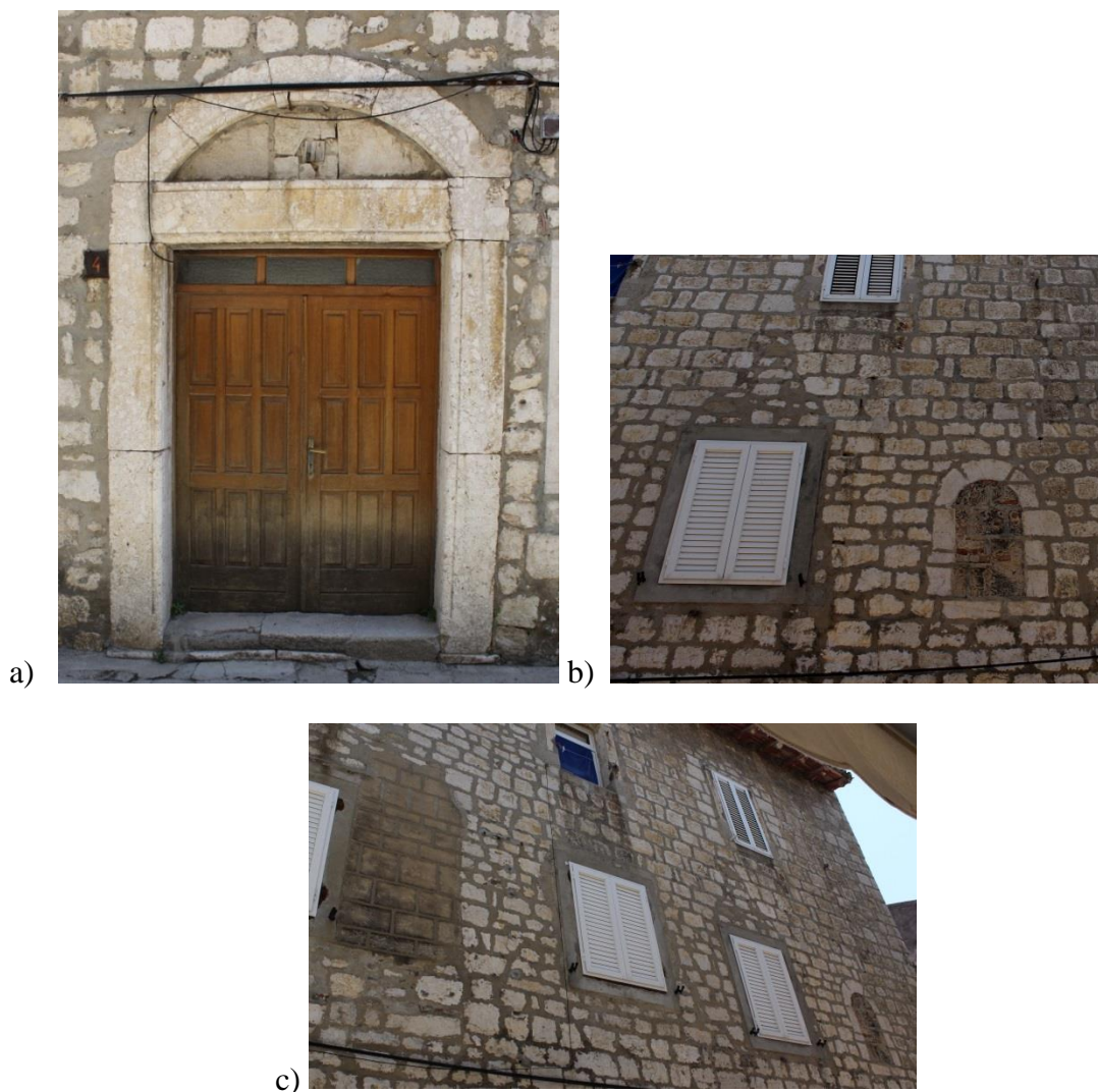
Slika 59: Stariji dijelovi građevine označene zeleno na slici 45: a) portal b) tragovi ranijih monofora c) pogled na prvi kat građevine s tragovima ranijih otvora (foto: autorica)
