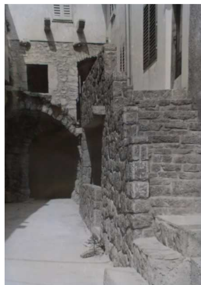
Sl. 58. Dogradnja stubišta, Mala placa 3, 4, 5. Puntat, 1977. 236
