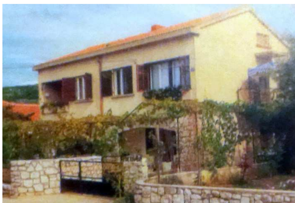
Sl. 49. Kuća, Frankopanska 75, Punat, 2000. 182
