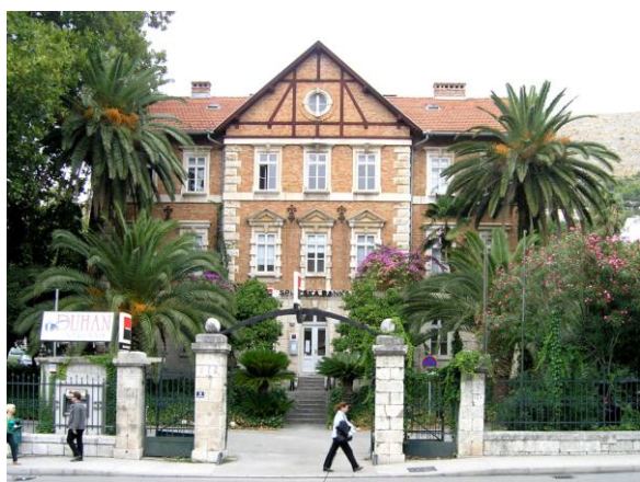
Sl.10. Upravna zgrada Duhanskog ureda u Gružu
