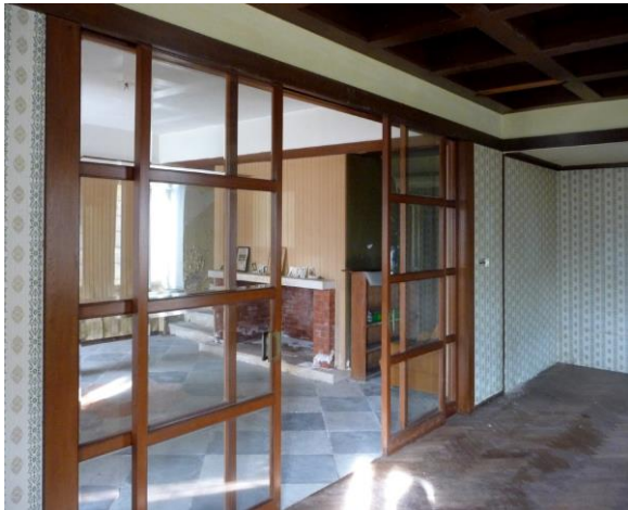
Vila Marka Ruska, pogled iz dvorane prizemlja u predvorje
