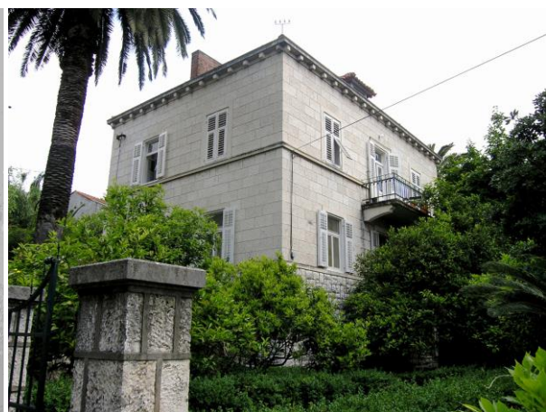
Kuća Jelke Miloš, pogled s jugozapada
