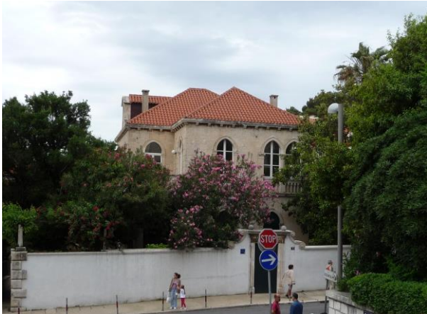
Sl.52. Kuća Luka Pehovca na Pilama
