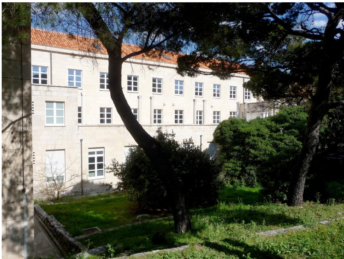
Zgrada OUZOR-a (Dom narodnog zdravlja), pogled na zapadno pročelje
