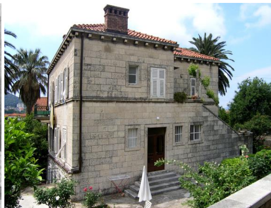
Sl.182. Kuća Jelke Miloš u Gružu
