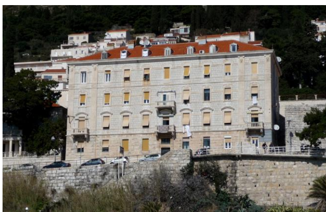
Sl.29. Kuća Banac na Pločama
