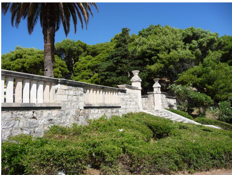
Prilazno stubište parku i ogradni zid
