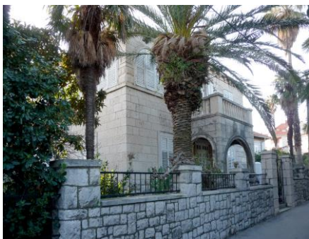
Kuća Điva Njirića, pogled s jugoistoka
