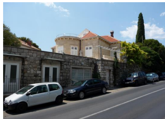
Kuća Cvetka Radojevića, današnje stanje
