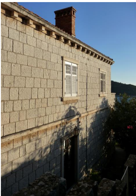
Kuća Karla Deškovića, zapadno pročelje
