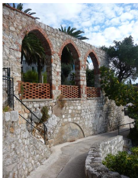
Vila Ćurlića, ogradni zid
