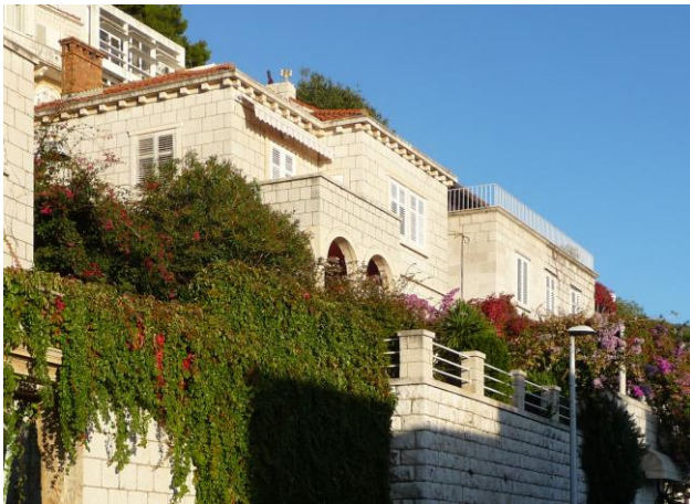
Kuća Karla Deškovića, pogled s jugozapada
