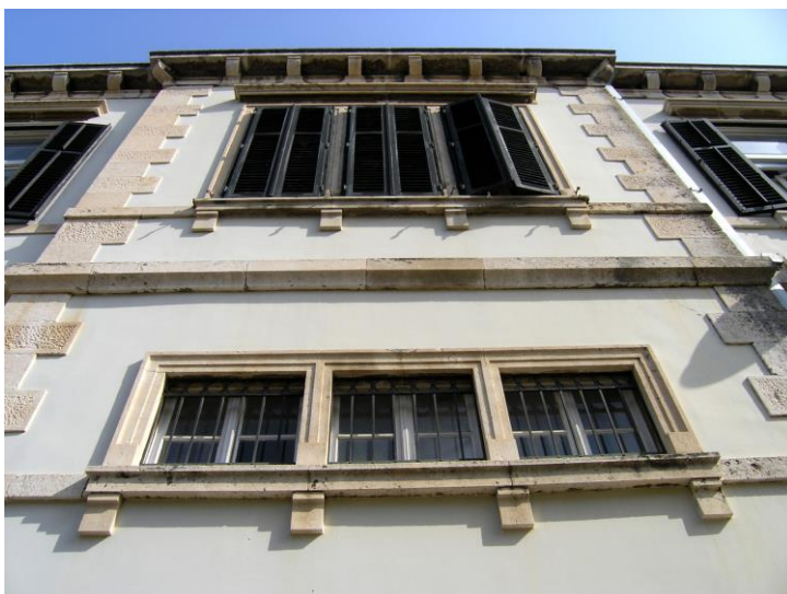
Upravna zgrada „Prvog dalmatinskog trgovačkog društva“, detalj pročelja
