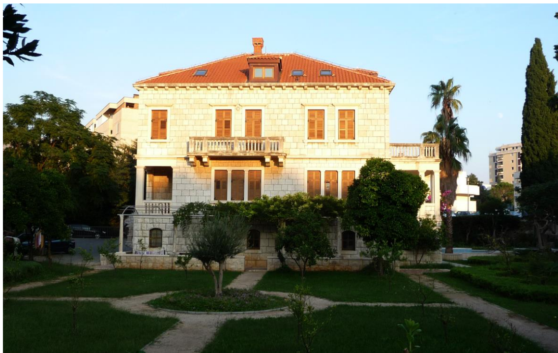
Pansion „Eden“, pogled sa zapada
