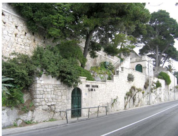
Stubište na Boninovu, pogled s jugozapada
