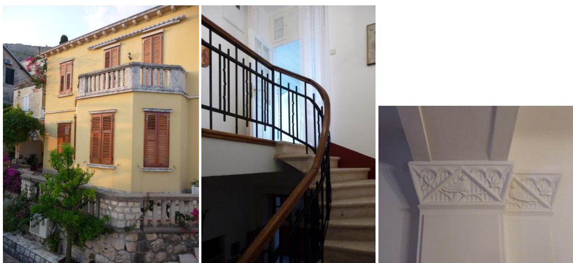
Vila „Zlatni potok“, južno pročelje, detalj stubišta, detalj pilastra između blagovaonice i salona
