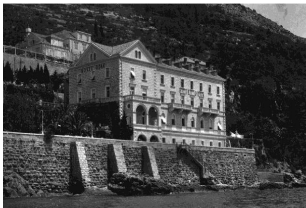
Hotel „Odak“, pogled s jugozapada
