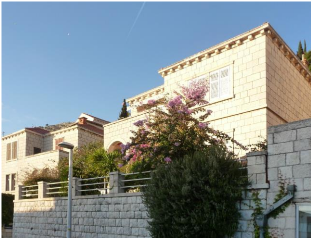
Kuća Karla Deškovića, pogled s jugoistoka
