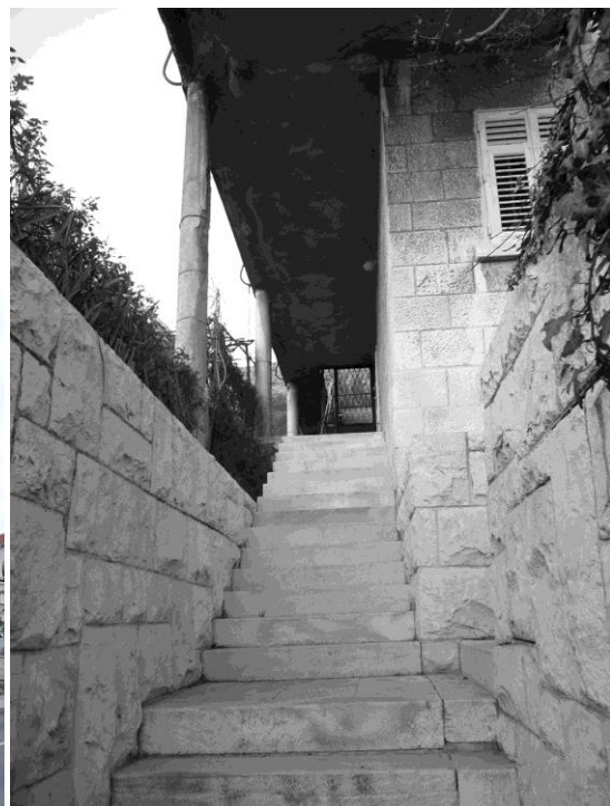
Kuća Pehovac - Sessa, detalj prilaznog stubišta i terase
