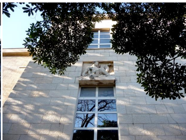
Zgrada OUZOR-a (Dom narodnog zdravlja), detalj pročelja
