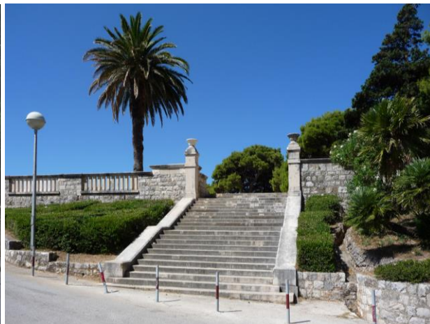
Sl.34. Park Gradac, prilazno stubište
