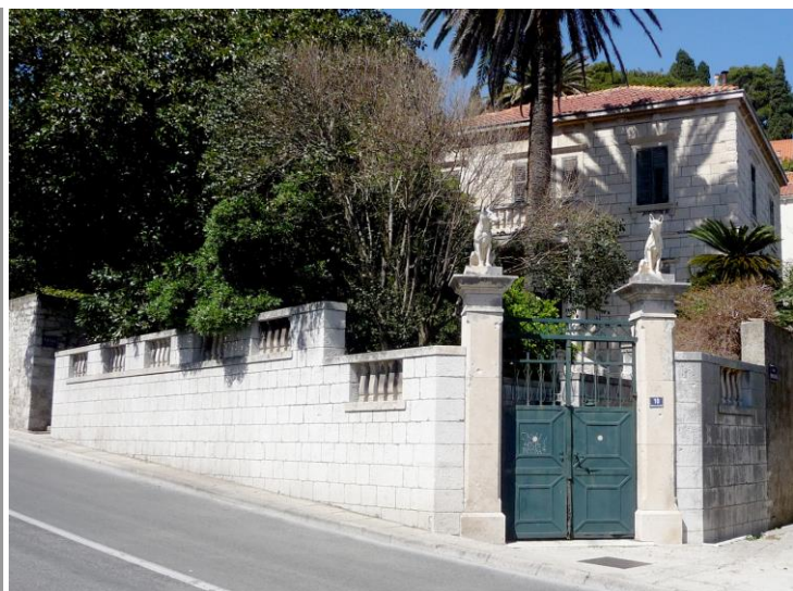
Vila Josipa Kalafatovića, pogled s ceste
