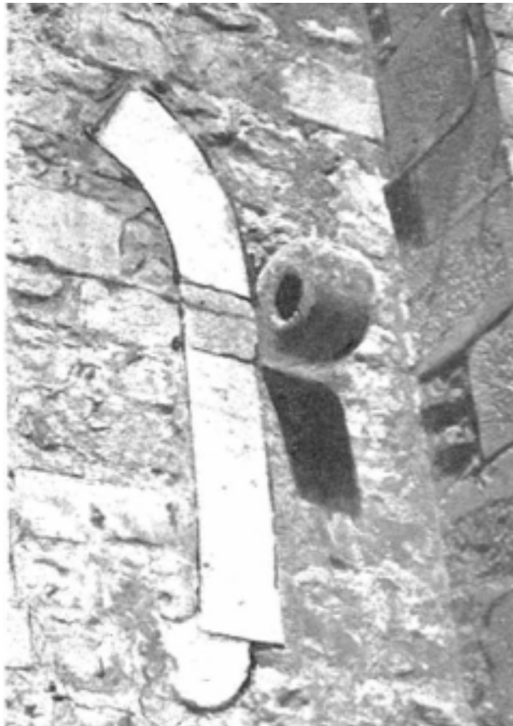
Sl. 12. Primjer kamenog prstena za rastiranje platna na još neuređenoj fasadi u Splitu
