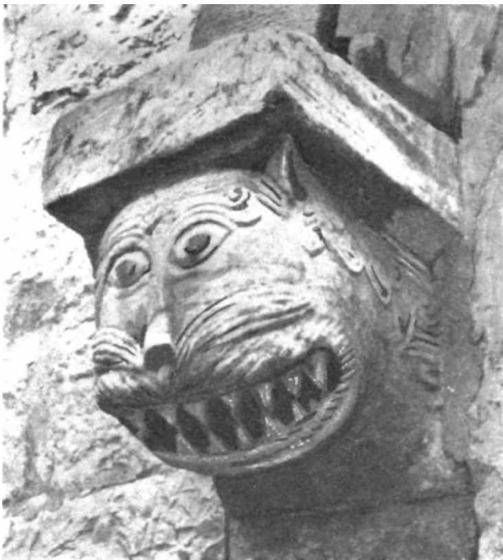
Sl. 15. Primjer točkova za odvod kišnice u Splitu i u Trogiru, u obliku lavlje glave
