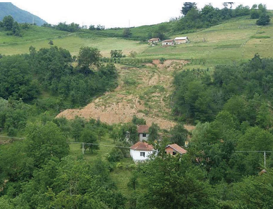
Слика 2. Сложени тип кретања, клижење и течење (Ребељ, Ваљево, 2014).
