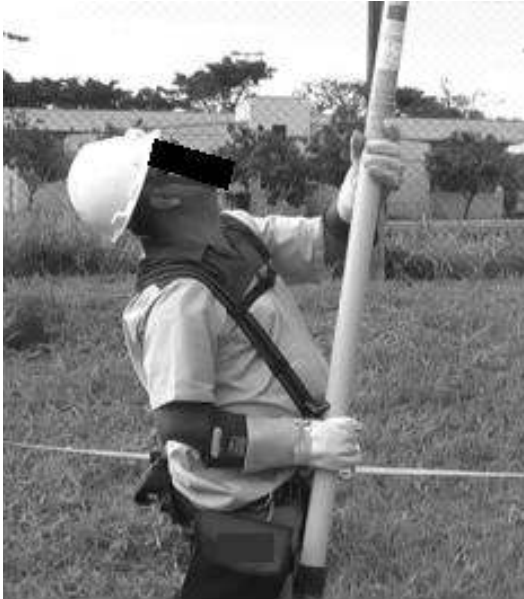
Figura 6. Eletricista durante atividade de troca de elo fusível em solo com uso da vara telescópica.
