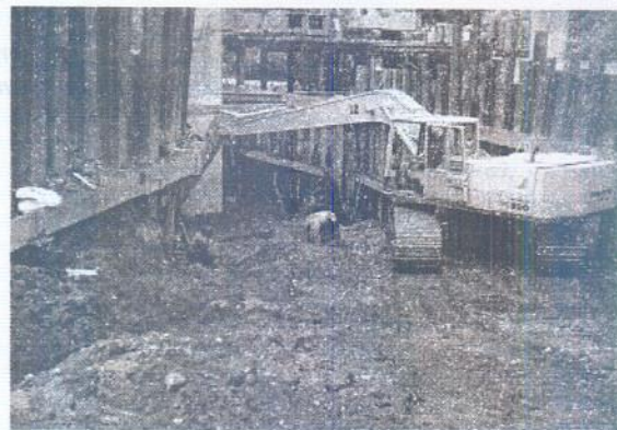
Pelaksanaan timbunan pada pilar (P1B)
