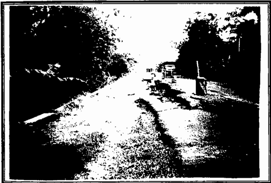
Gambar 5. Foto lokasi jalan di KM 172 + 800 yang mengalami longsor
