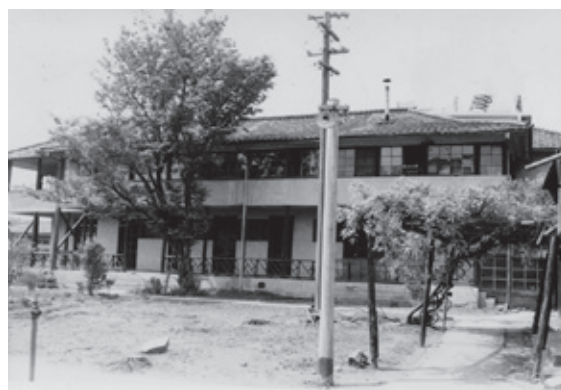
図6 デントン・ハウス外観 【ベランダにコンクリートの帯をなし、その他に補強したのは戦時中である】 【 】は、本学元職員・山田健三による説明文を示す。
