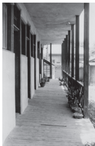
図8 デントン・ハウス ベランダ 【ここから出入りをする。前庭からの入口である。集会などいつも左に廻ると台所入口に出る右端に見たところ。先方に温室が見える。客間食堂外側の縁先を西より東に。】
