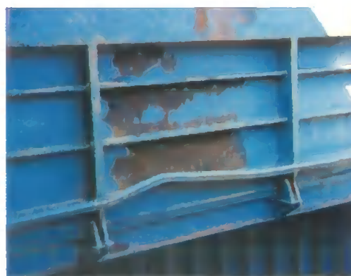
Fig. 5.2 A deformed longitudinal
