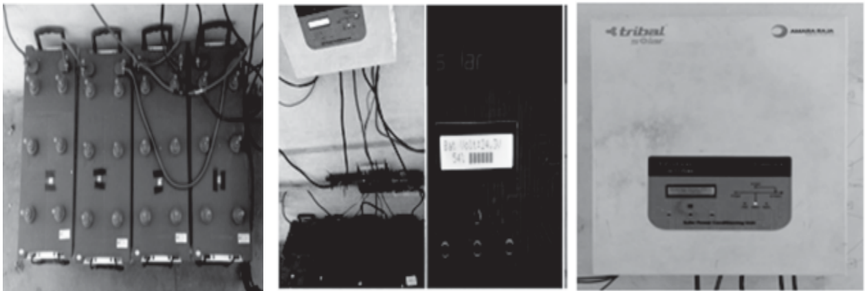
चित्र 4 – (a) 12V, 100Ah बैटरी बैंक (4 नं), 4(b) सौर ऊर्जा कंडीशनिंग यूनिट (एसपीसीयू), 4(c) बैटरी बैंक से जुड़े एसपीसीयू बैटरी वोल्टेज और एसओसी प्रतिशत को प्रदर्शित करता हुआ
