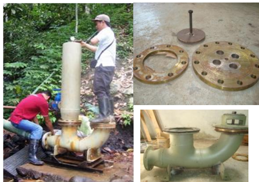
Gambar 1. Perakitan pompa hydram
