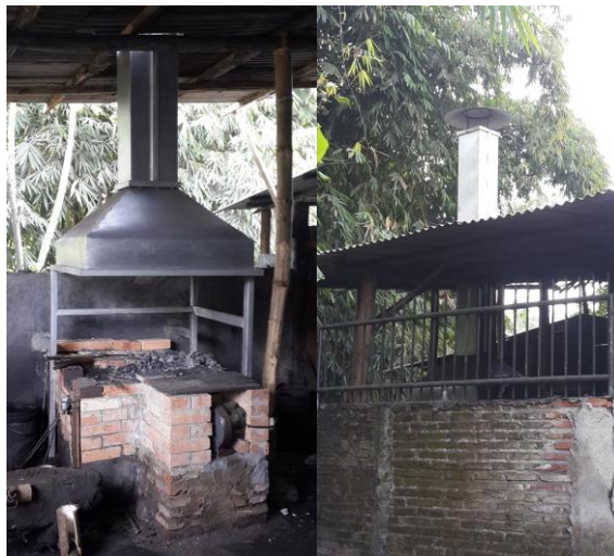
Gambar 7 Tungku Pembakaran/ Perapen Besar dengan Cerobong
