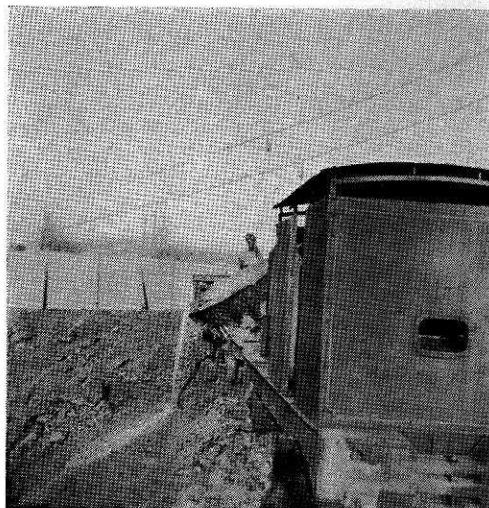
FIG. 4 — DUMPING OF SLAG
