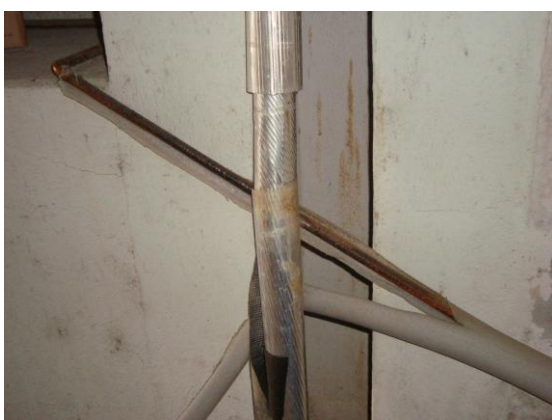
Tubulação de vapor exposta
