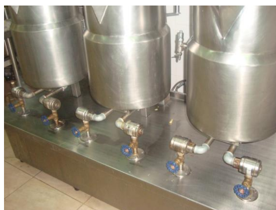
Registro para controle de vapor
