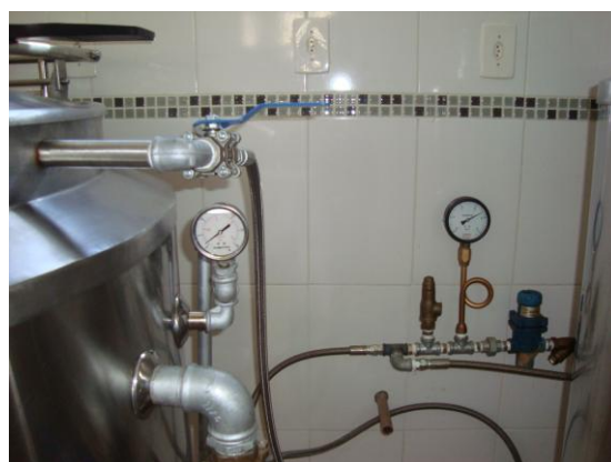
Manômetros e válvula de segurança
