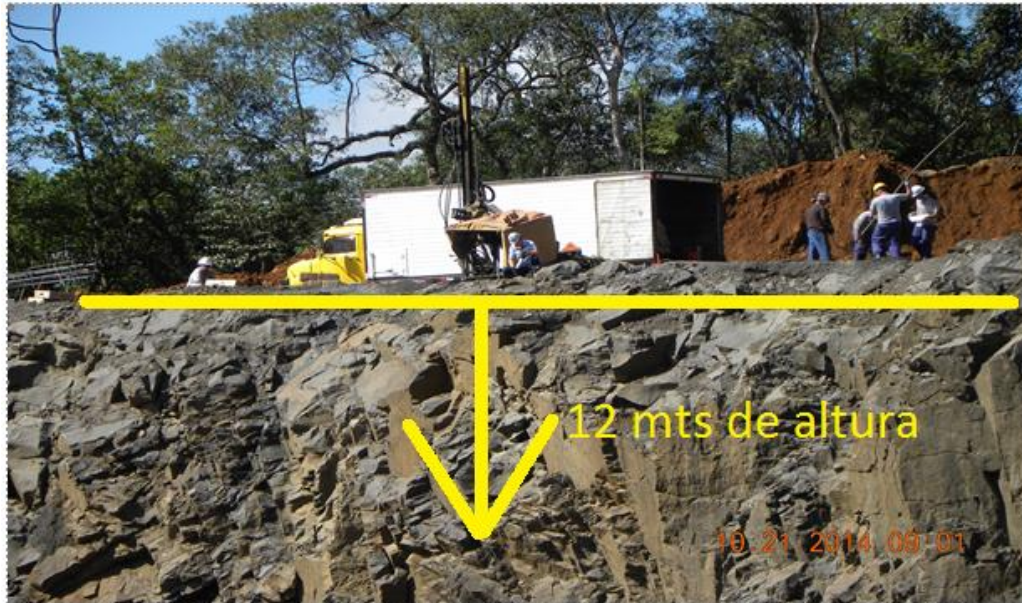
Figura 3 - Processo de carregamento de explosivo
