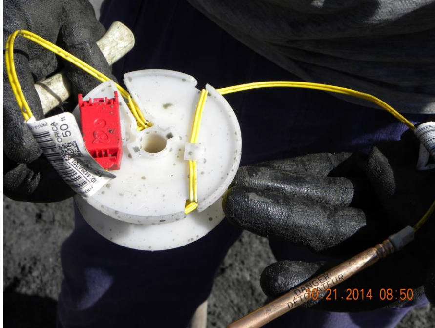
Figura 9 - Uso de EPI's no carregamento de explosivos
