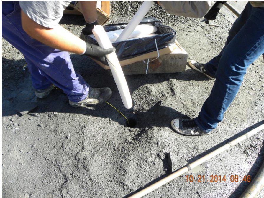
Figura 4 - Processo de carregamento dos explosivos nos furos da bancada.
