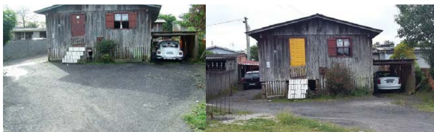
Imagens 05 e 06 - Moradia construída sobre rejeito de carvão, em 2011 (esq.) e em 2016
