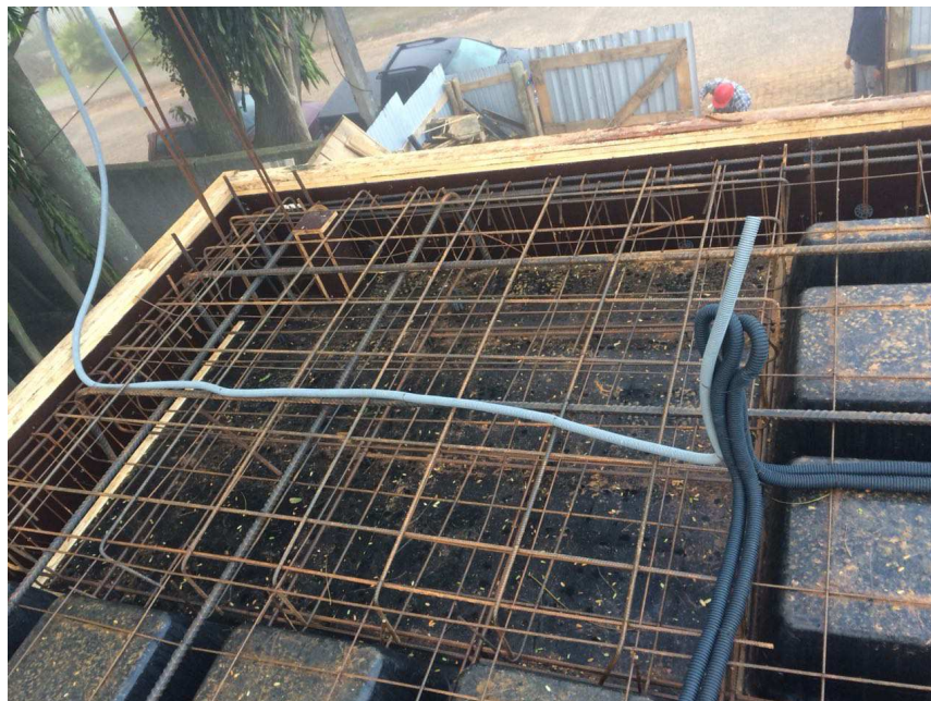
Figura 05: Armadura dos capitéis do 1º tipo
