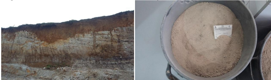
Figura 2: Vista frontal do talude; solo seco e peneirado.
