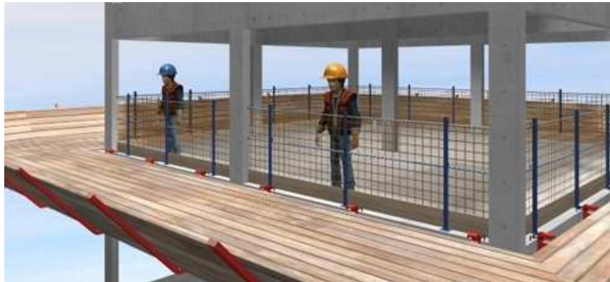
Figura 22 – Utilização de telas para cobertura de periferia de edificações
