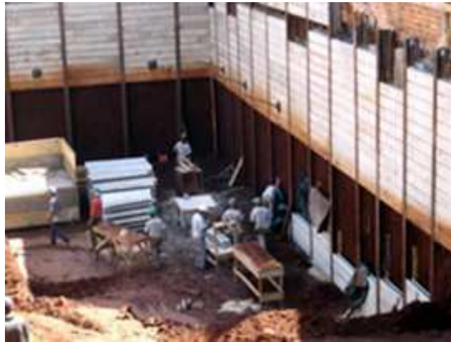
Figura 17 – Construção de fundação em níveis abaixo do nível normal do solo
