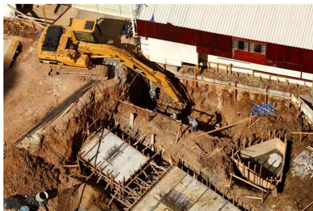
Figura 15 – Execução da Fundação
