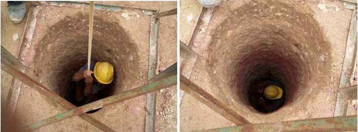
Figura 16 – Descida de um operário para execução da base do tubulão
