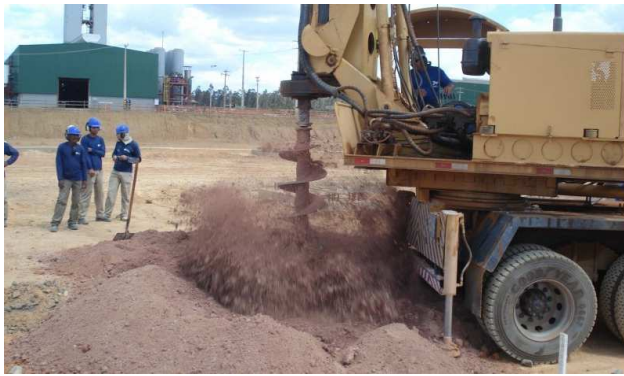
a) Perfuração do tubulão
