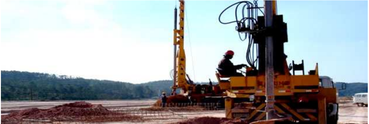
Figura 5 – Fixação de estacas por vibração
