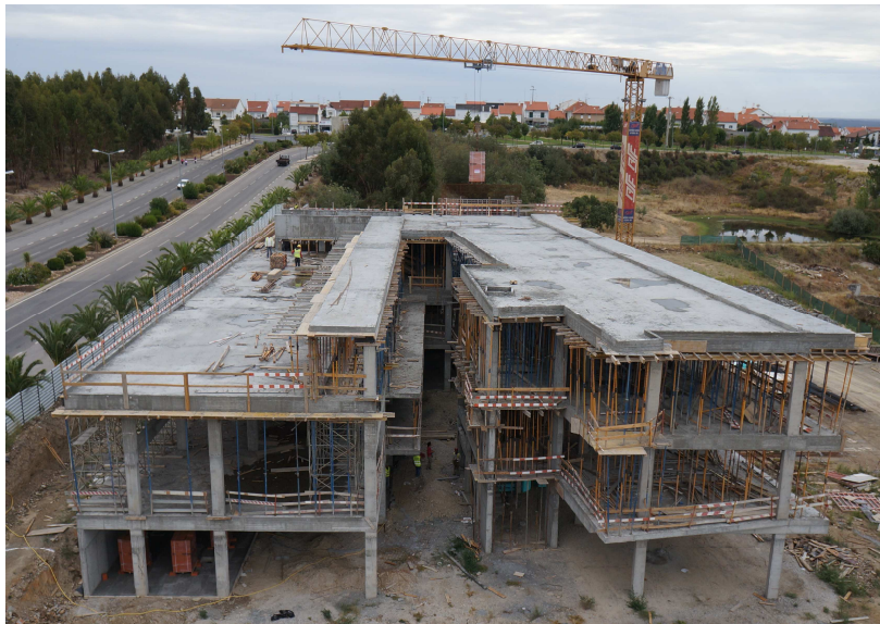
Figura 10 – Construção de 3 pavimentos
