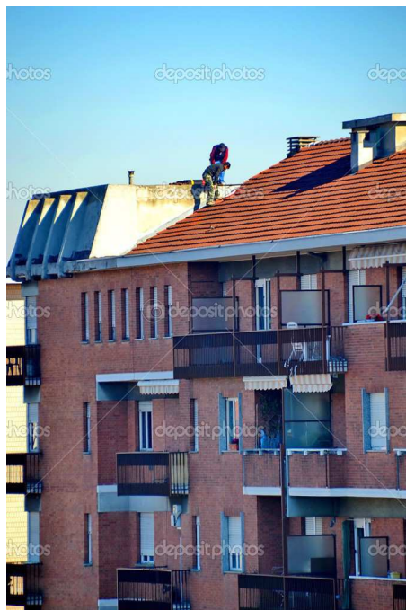
Figura 12 – Edificação com telhado como arquitetura do topo da construção
