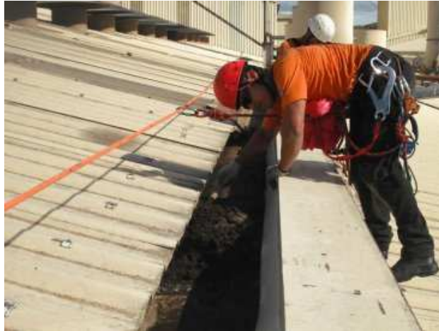
Figura 25 – Execução da manutenção de telhados
