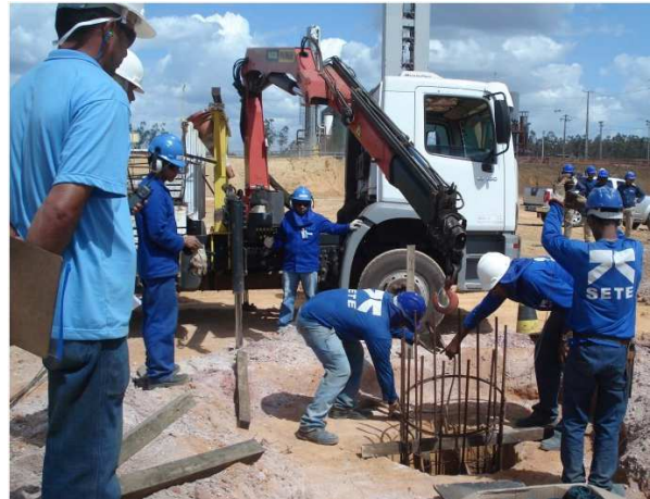
c) Montagem da armadura
