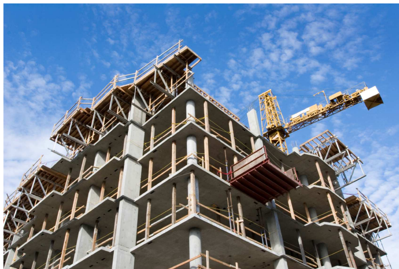
Figura 11 – Edifício de múltiplos pavimentos
