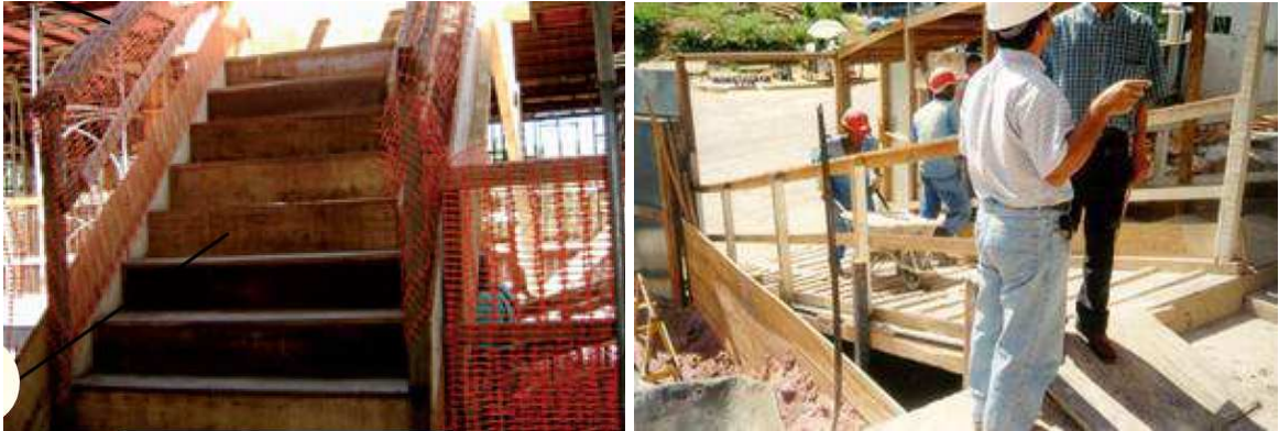
Figura 19 – Escada e rampa de uso coletivo
