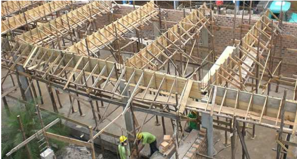
Figura 9 – Construção do Térreo
