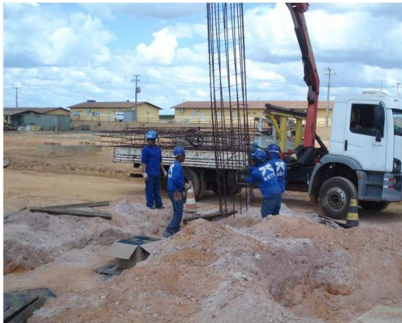
c) Montagem da armadura
