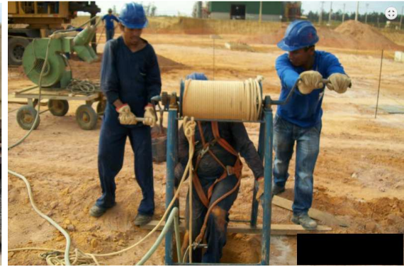
b) Execução da base
