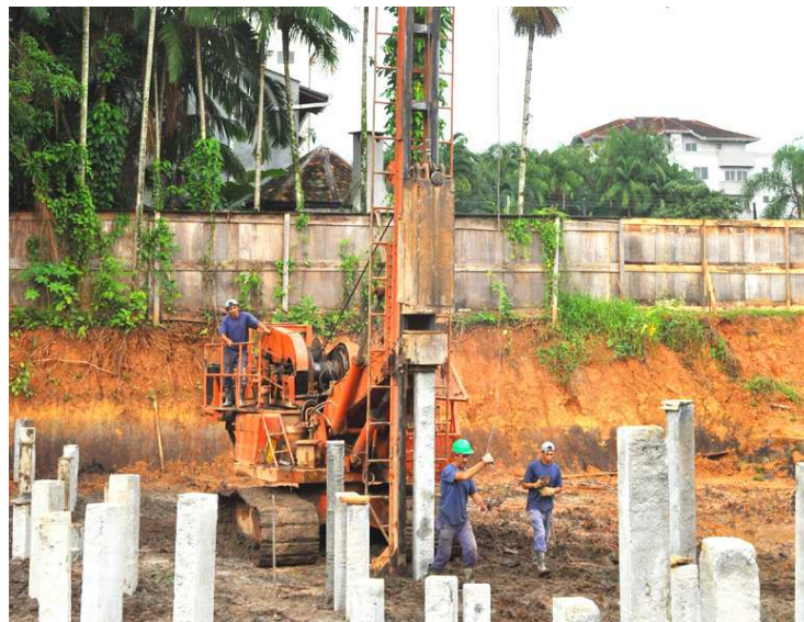
Figura 6 – Estaca cravada por percussão
