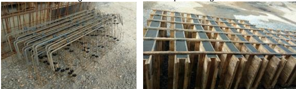
Figura 3: Detalhe da fabricação das vigas.
