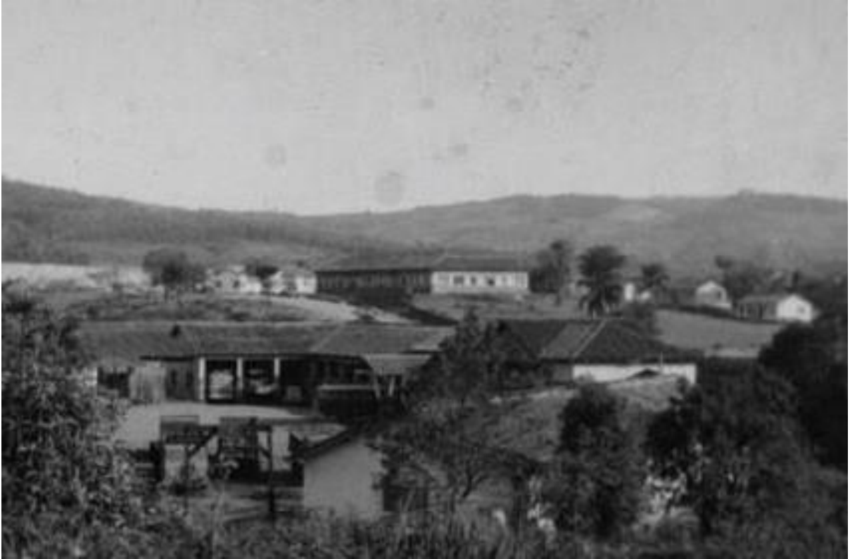
Figura 7 - Vista do escritório da CSN, abaixo o prédio das oficinas. Data: provável década de 1960.
