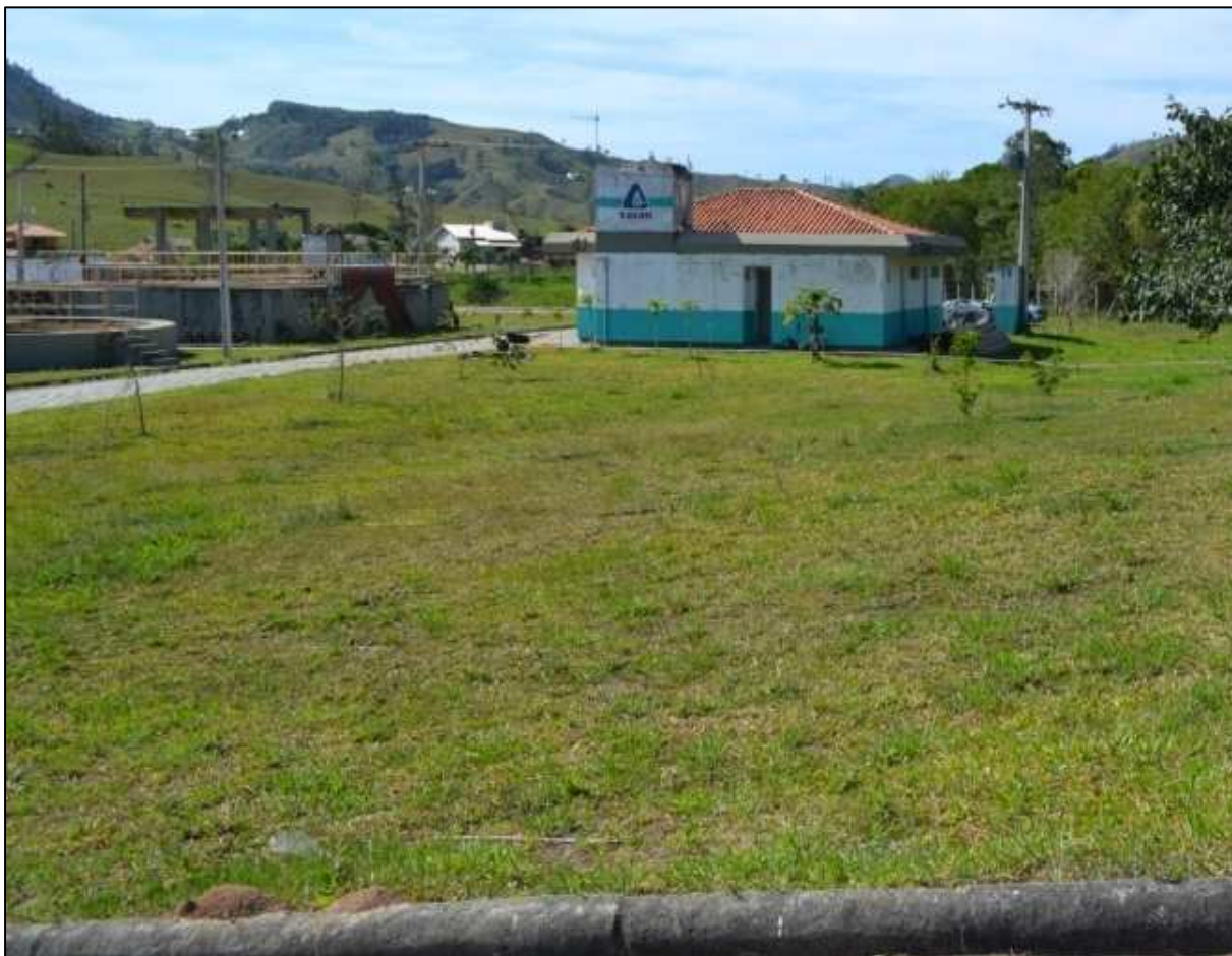
Figura 4 – Área da ETE Gravatal
