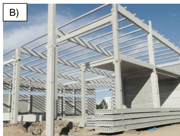
Figura 01: Coberturas de galpão pré-fabricado: A) pórtico atirantado e B) vigas de concreto protendido.
