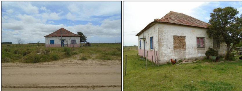
Figura 2 – Fachada e entorno da edificação com destaque para as aberturas, uma da qual fechada com tijolos
