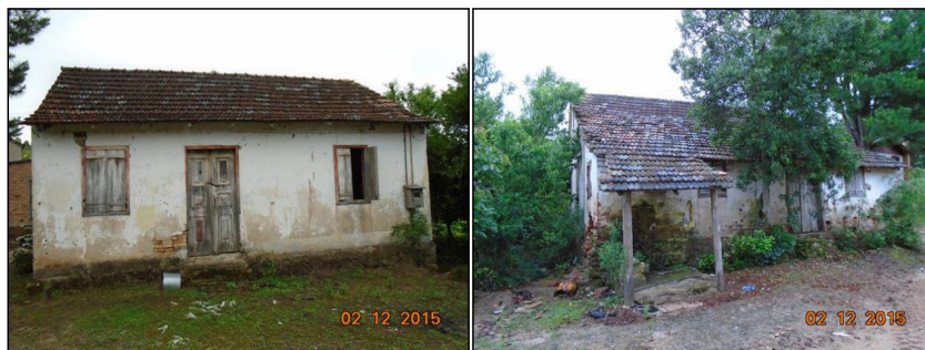
Figura 3 – Vista frontal e vista dos fundos da casa
