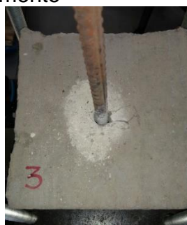
Figura 11 – Ruptura por fendilhamento
