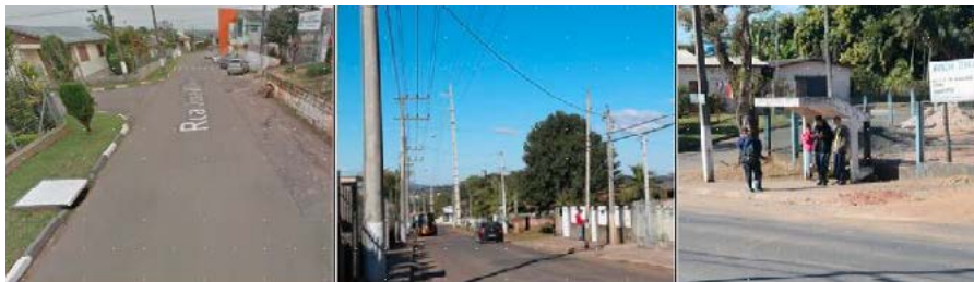
Figura 10 – Diferentes situações das vias e calçadas, demonstrando falta de padrão. Calçadas sem acessibilidade, postes implantados no meio de calçadas e passeios públicos inexistentes
