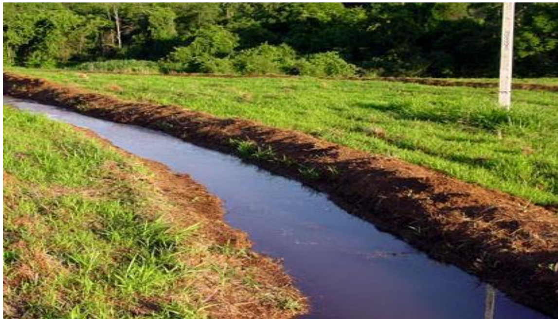
Figura 7: Canal de infiltração com chuva Fonte: IPEC apud RAINHO 2005
