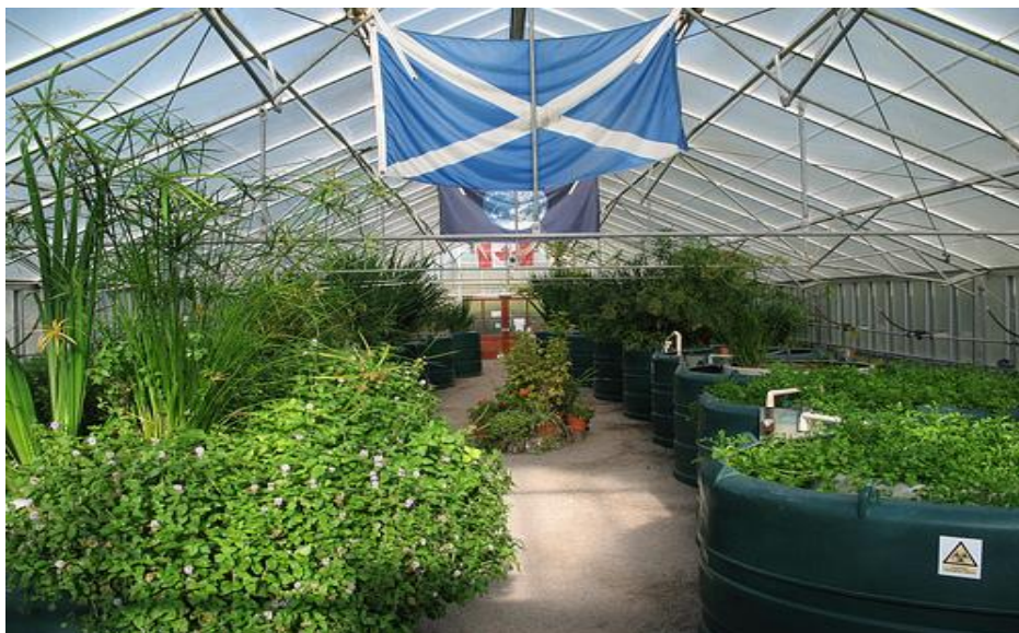
Figura 13: Tanques aeróbicos Fonte: BRAUN (2001)
