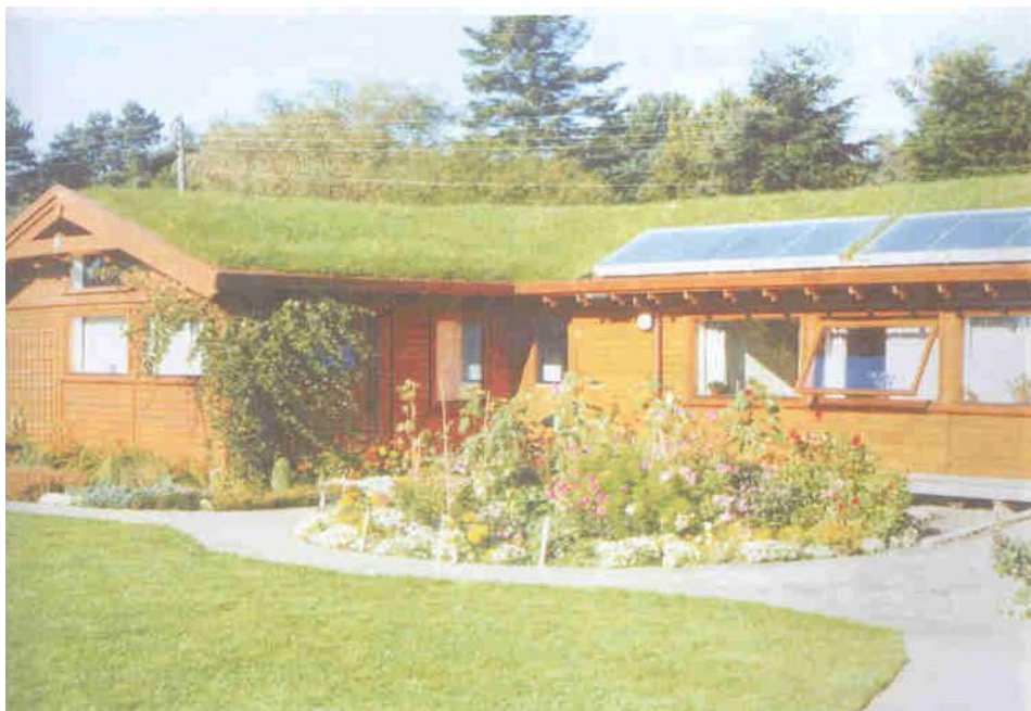
Figura 11: Residência em madeira em Findhorn com telhado verde e coletor solar Fonte: BRAUN (2001)
