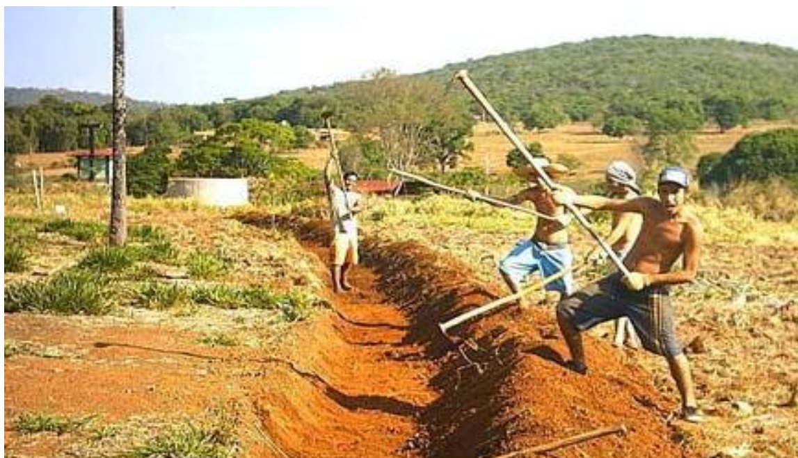
Figura 6: Execução de canal de infiltração Fonte: IPEC apud RAINHO 2005
