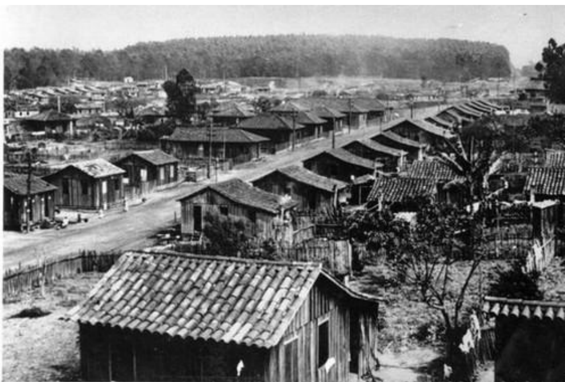
Figura 12: Rua Geral do bairro Próspera (fotografia da década de 1950)
