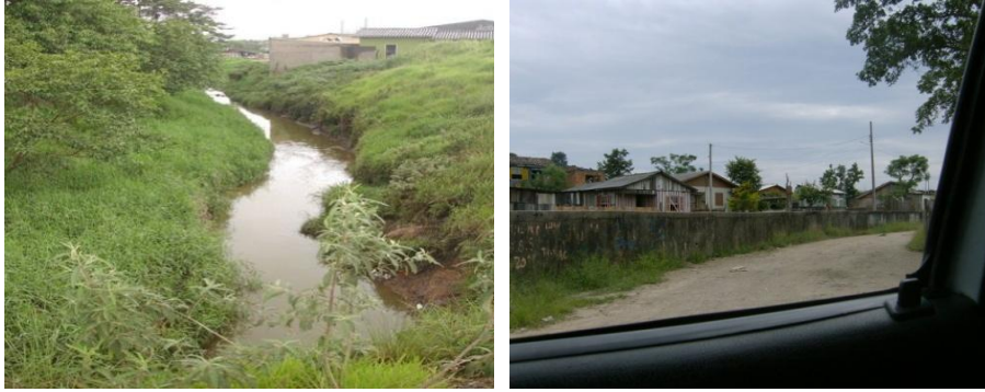
Ilustração 8 - Esgoto a céu aberto à esquerda / esgoto drenado à direita.
