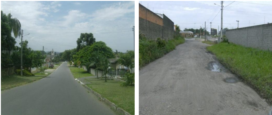
Ilustração 10 – Rua pavimentada à esquerda / Rua sem pavimentação à direita.
