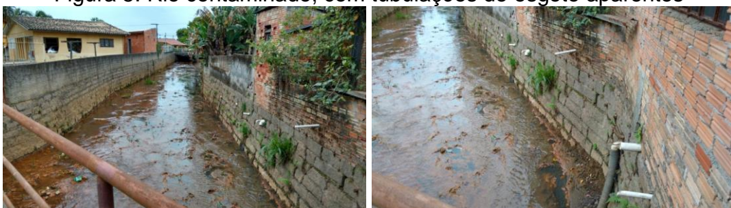
Figura 5: Rio contaminado, com tubulações de esgoto aparentes
