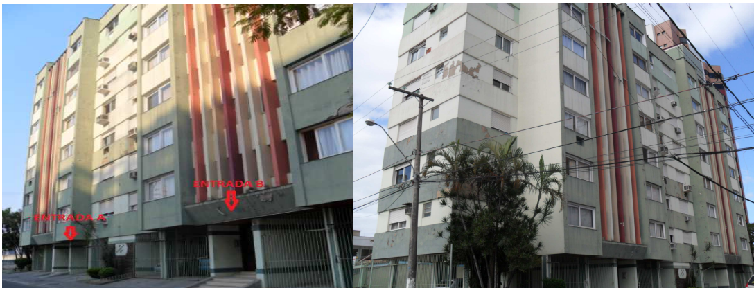
Figura 01: Fachadas do Edifício Residencial
