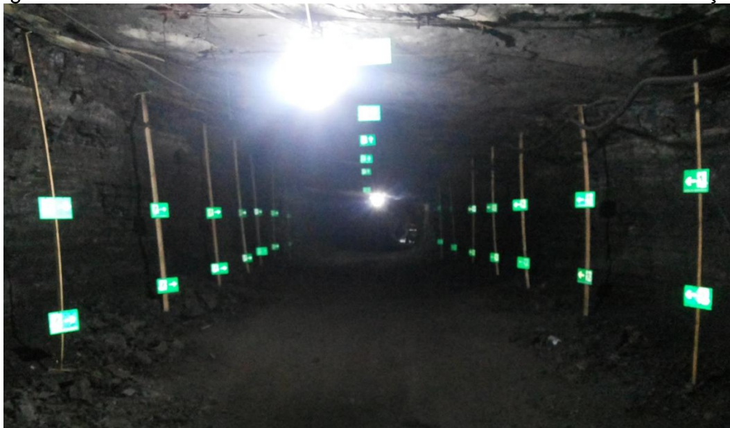
Figura 13: Galeria sinalizada em ambos os lados e no teto e com iluminação
