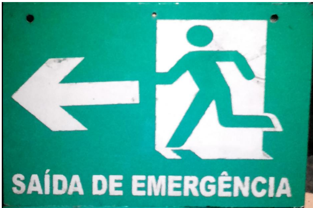
Figura 9: Placa de Sinalização de emergência Fixada a 0,50m e a 1,80m do piso(Lapa) na lateral direita da galeria no sentido subsolo/superfície.
