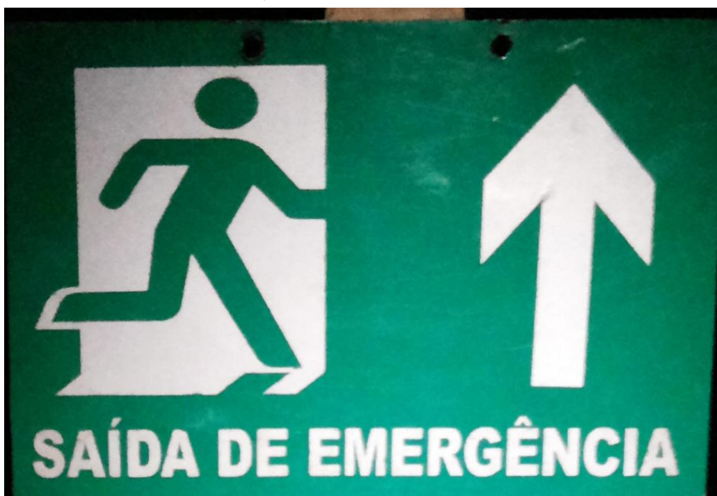
Figura 8: Placa de Sinalização de emergência Fixada no teto da galeria.
