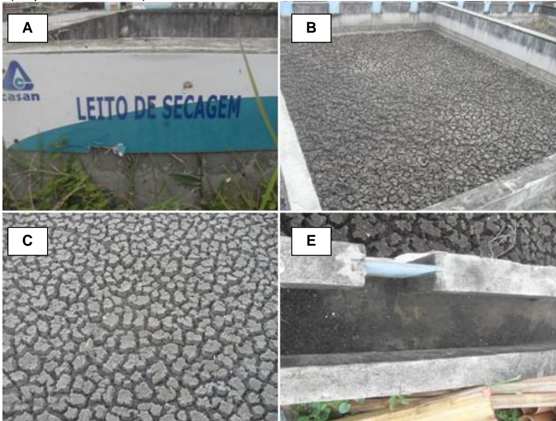
Figura 7 - Leito de secagem, onde: A) Identificação; B) Vista de 1 leito de secagem; C) Aspecto do lodo; D) Calha de entrada
