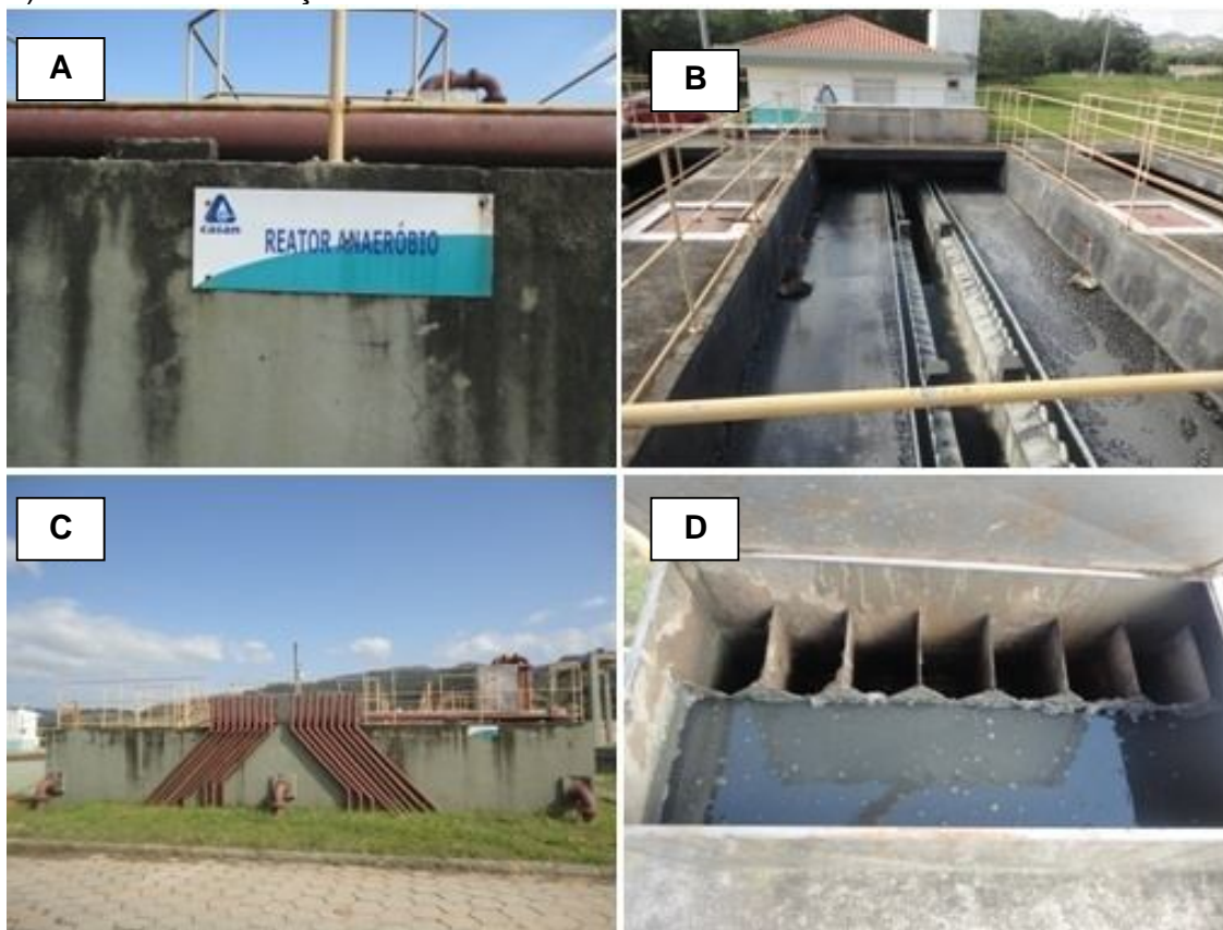
Figura 5 - Reator Anaeróbio, onde A) Identificação; B) Vista superior; C) Vista lateral D) Caixa de distribuição
