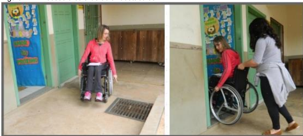
Figura 11 – Acesso à sala de aula: obstáculos
