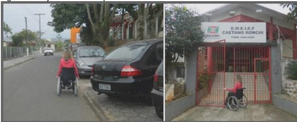
Figura 6 – Trajeto de acesso e portão de entrada da escola
